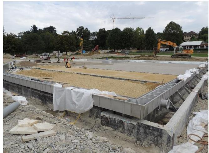
Abbildung 2 Beispiel eines Edelstahlbeckens im Bau, Prilly Lausanne
