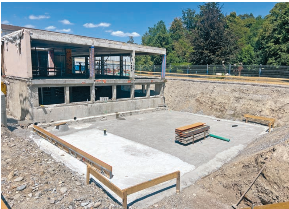
Oben: Neue Beton-Bodenplatte anstelle bestehender, zu schwacher Bodenplatte. Links: Bodenplatte Erweiterung Pavillon 3.
