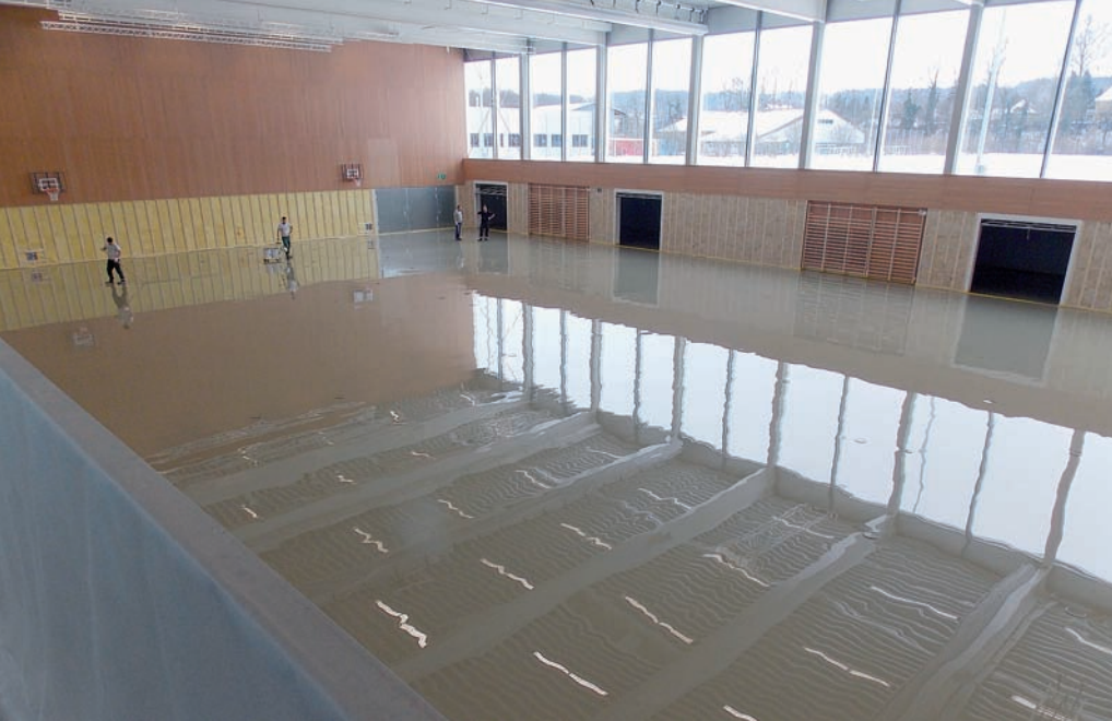
Der selbstnivellierende Kunststoffbelag wird gerade eingebracht. Darüber wird dann noch eine zweite Schicht gegossen und dann können die Linien aufgemalt werden.
